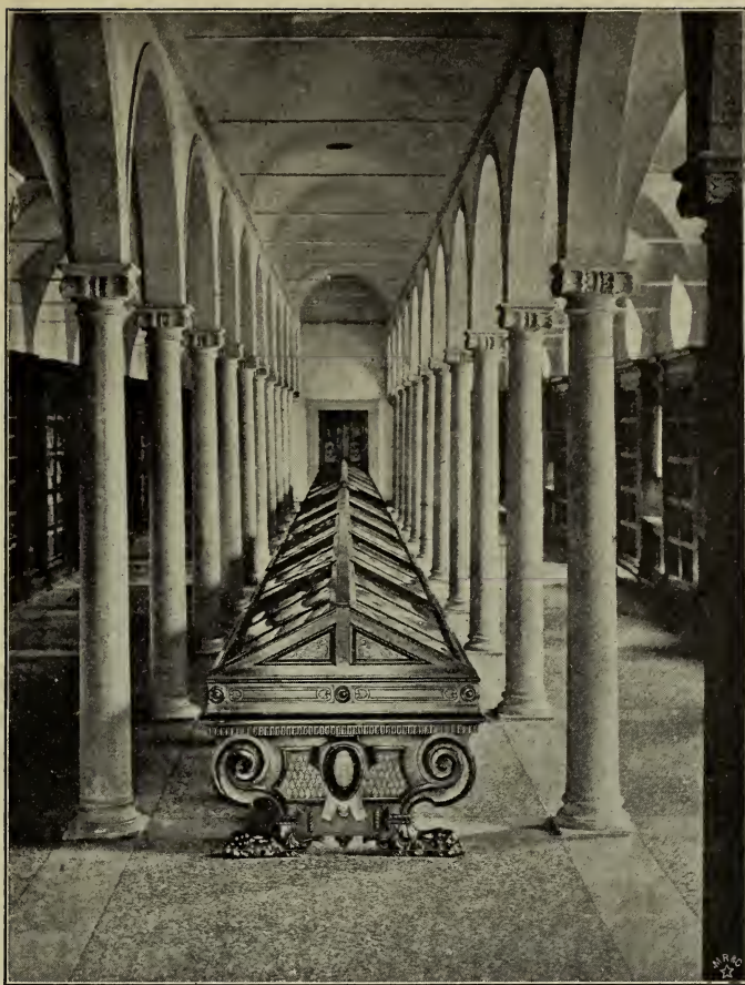
Abb. 48. Bibliothek in San Marco, erbaut von Michelozzo. (Nach einer Photographie von Gebr. Minari, Florenz.)
